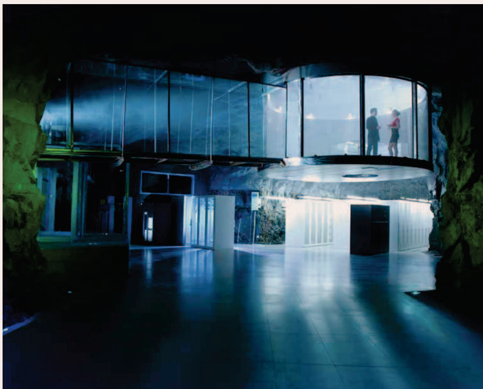
ELINTENSIVT. Internetleverantören Bahnhof ska bygga ett stort datacenter i Stockholm, där bolaget kommer att samarbeta med Fortum Värme. Energibolaget hoppas kunna locka fler datacenter till Stockholm med erbjudanden om billig energi.
