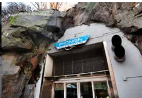
2014: Idag återvinns överskottsvärmen och säljs till Stockholms fjärrvärmenät.
