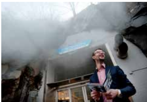
2007: När Bahnhof öppnade datahallen Pionen släpptes överskottsvärmen ut som en ångkvast rakt ut på gatan.
